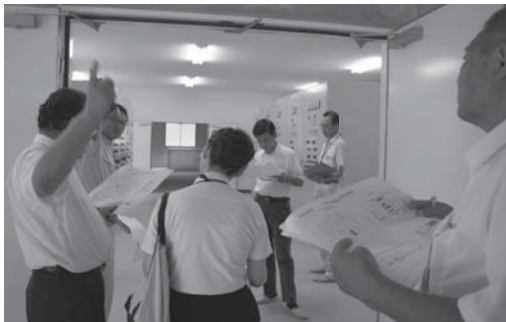
落合浄水場電気設備工
